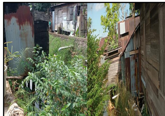
Gambar 5. Bangunan Warga Masuk Sempadan Sungai
