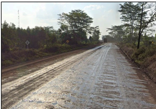
Gambar 9. Kondisi Jalan Angkut
