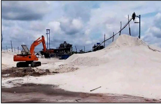
Gambar 7. Tumpukan pasir kuarsa hasil dari pompa sedot
