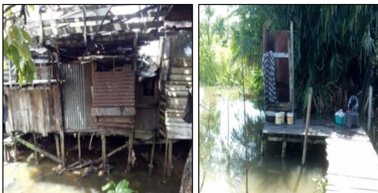
Gambar 3. Sistem Pengelolaan Air Limbah Tidak Sesuai Standar Teknis
