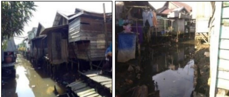
Gambar 2. Ketidak Teraturan Bangunan
