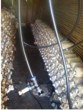
Gambar 8 Memasang Selang Input
