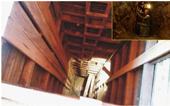
Gambar 10 Salah satu terowongan panambangan emas pada pertambangan rakyat di Desa Cihonje, Kecamatan Gumelar, Kabupaten Banyumas. (Sumber: localexpert.wordpress.com)
