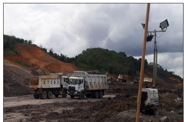
Gambar-5. Kondisi Pemuatan Material
