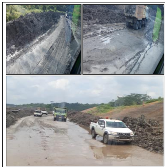
Gambar-6. Kondisi Jalan Angkut
