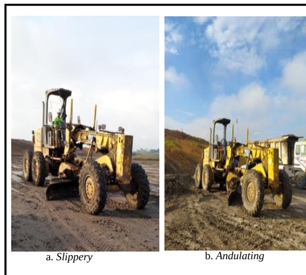
Gambar-8. Perawatan Jalan Menggunakan Grader
