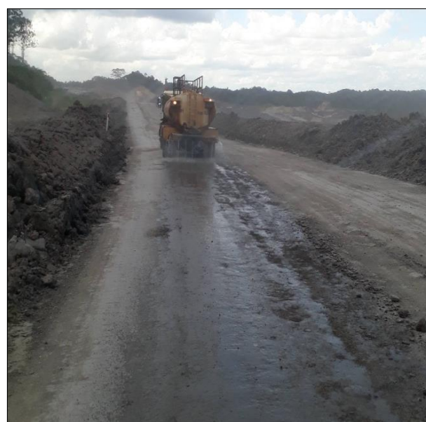
Gambar-9. Perawatan Jalan Untuk Optimalisasi Pemuatan Material
