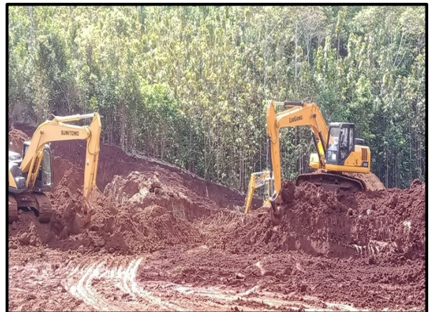
Gambar-9 Proses pengupasan Top Soil dan Overburden
