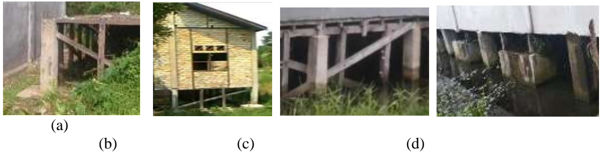
Gambar 12. Penggunaan Tiang Beton Pada Deretan Tiang Kayu
