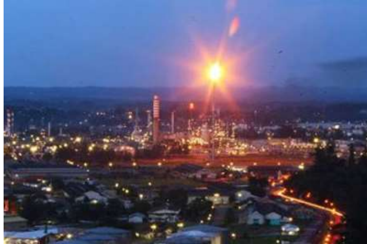
Gambar 3. Flare stack PT. Pertamina RU V setelah dioperasikan kembali
