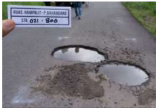
Gambar 4.5 Kerusakan Lubang
