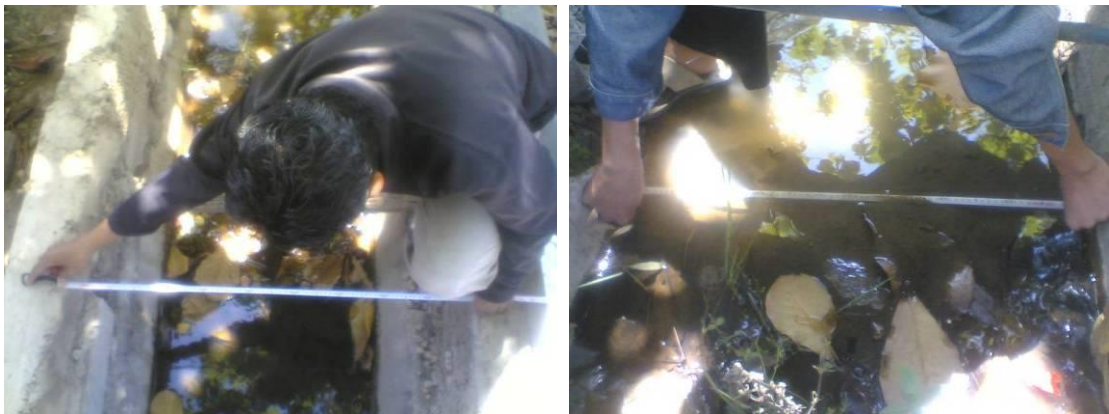
Gambar 7. Lebar bagian atas saluran 90cm dan Lebar bagian bawah saluran 70cm
