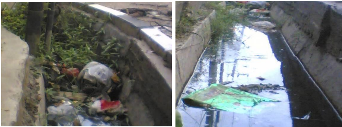
Gambar 6. Saluran drainase di Jalan GatotSubroto
