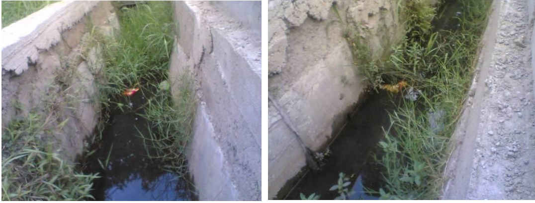
Gambar 5. Saluran drainase di Jalan GatotSubroto
