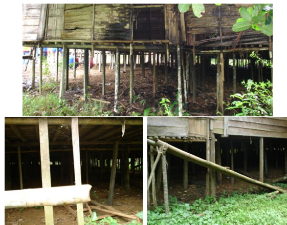
Gambar 10. Konstruksi Tiang dan Tongkat pada Rumah Balai
