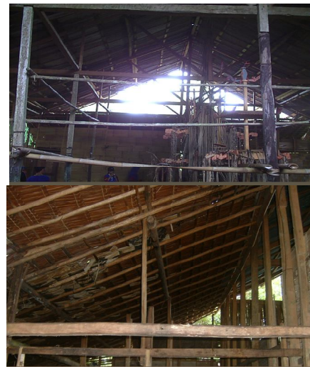
Gambar 23. Konstruksi Kuda-Kuda Rumah Balai (Sumber: Arsip Penulis; 2006)
