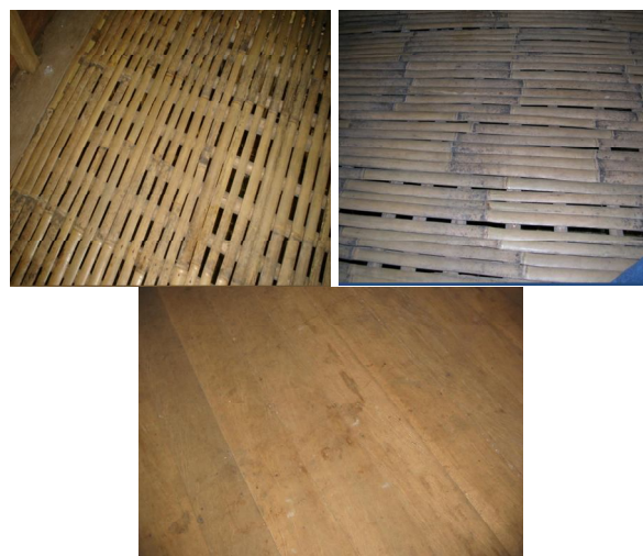
Gambar 11. Konstruksi Lantai pada Rumah Balai Sumber: Arsip Penulis, 2006
