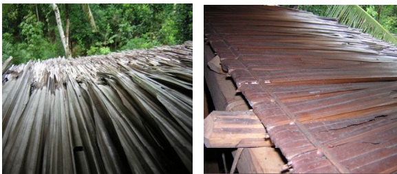
Gambar 20. Daun Rumbia sebagai Material Penutup Atap Rumah Balai Sumber: Arsip Penulis, 2006
