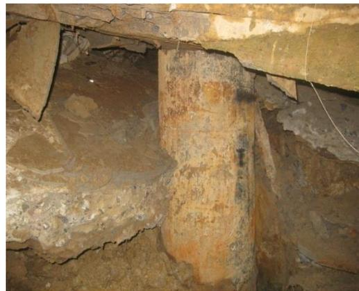
Gambar 2. Pondasi tiang pada abutmen
