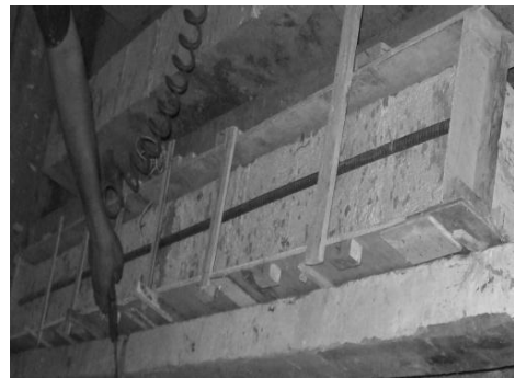
Gambar 2. Pembersihan benda uji dan pengolesan Bonding Agent
