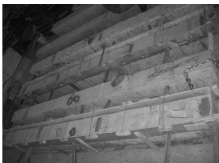
Gambar 1. Bekisting dan tulangan longitudinal untuk perkuatan daerah tarik dan tekan
