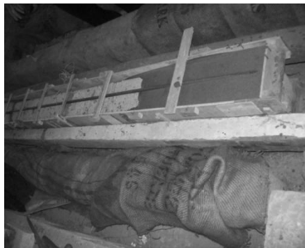
Gambar 3. Pengecoran perkuatan dengan mortar
