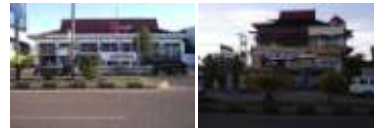
Gambar 7. Bangunan Gaya Tradisional
