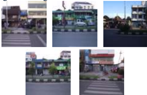
Gambar 6. Fenetrasi pada bangunan
