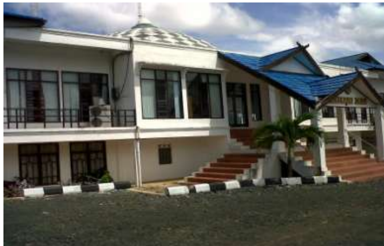
Gambar 1. Struktur Bangunan Gedung pendopo Iman
