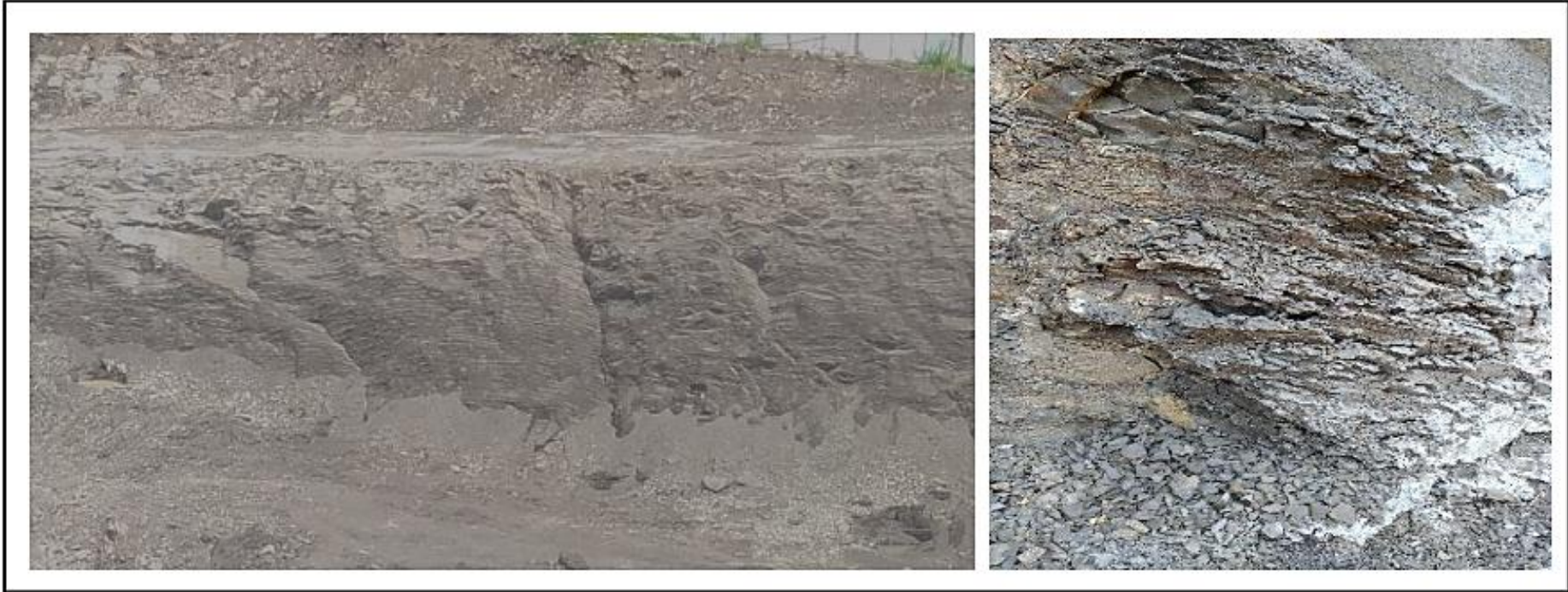
Kondisi tanah Clay Shale di Sentul City yang sudah terbuka
