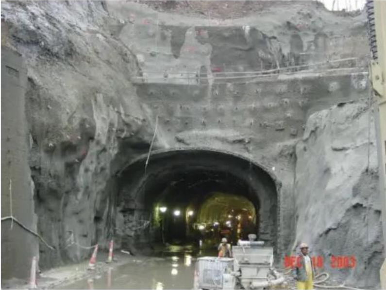
Gambar 4. Pembuatan terowongan dengan perkuatan shotcrete (sumber : http://www.gzconsultants.com/?attachment_id=3573 )
