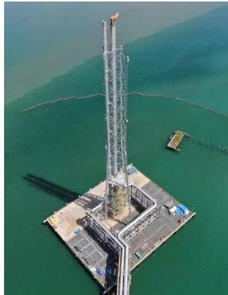
Gambar 7. Riser Flare Stack Telah Terpasang dan Berfungsi
