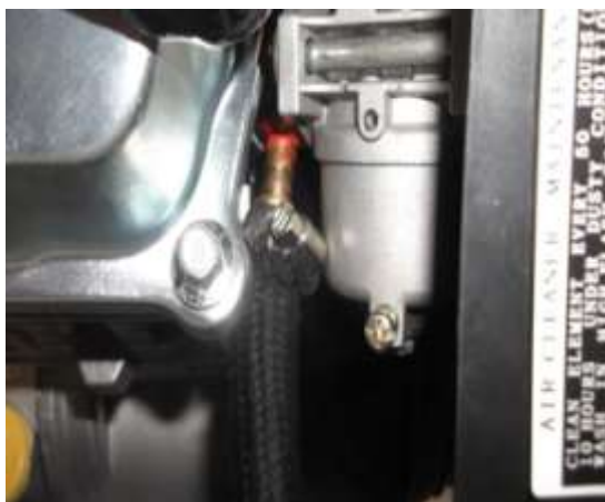
Gambar 8. Hasil instalasi insulator yang telah dimodifikasi pada generator set
