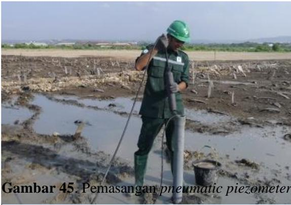
Gambar 45. Pemasangan *pneumatic piezometer*
