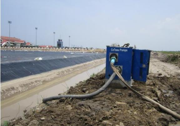
**Gambar 68.** Pekerjaan pompa *vacuum*
