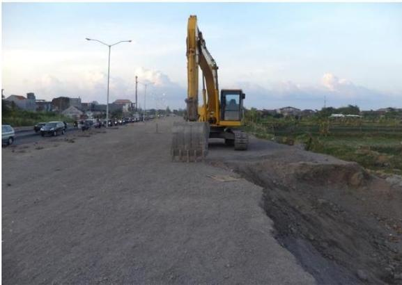
**Gambar 64.** Pekerjaan pembongkaran *preload*
