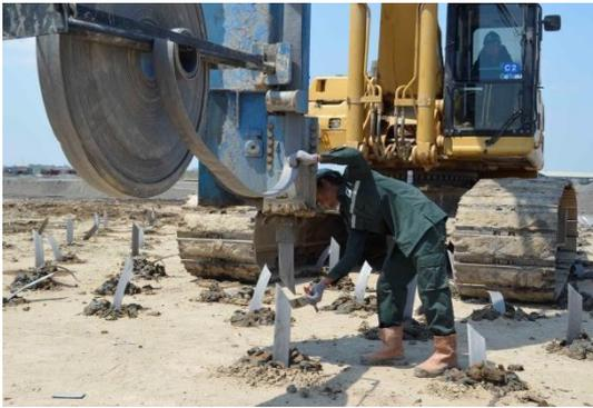
**Gambar 28.** Pemotongan PVD di atas tanah
