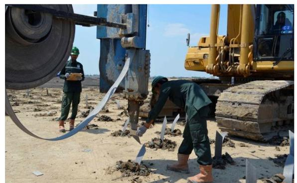
**Gambar 26.** Pemasangan sepatu pelat
