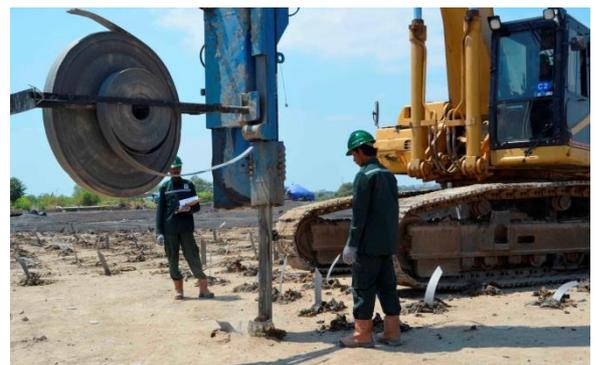
**Gambar 27.** Pemancangan *mandrel* ke tanah
