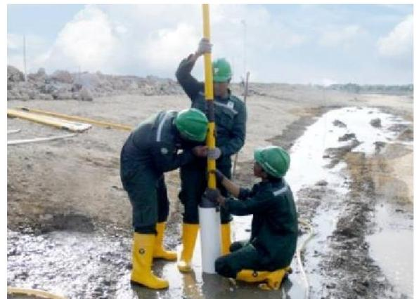
Gambar 50. Pemasangan *inclinometer*
