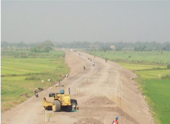
**Gambar 63.** Pekerjaan *preload*
