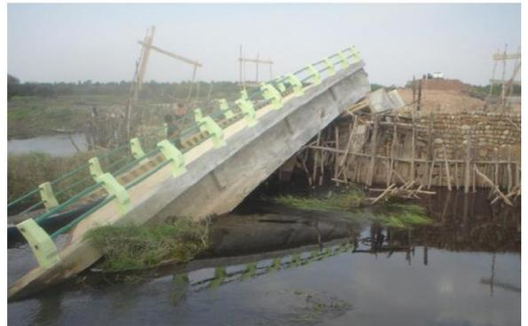
**Gambar 8.** Kerusakan konstruksi jembatan
