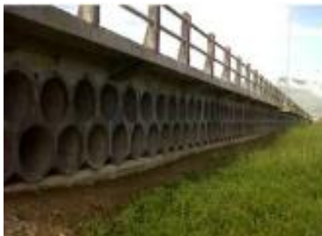
Gambar 3. Aplikasi Sistem Cakar Ayam Modifikasi di Jalan Simpang Batang-Lubuk Gaung propinsi Riau.
