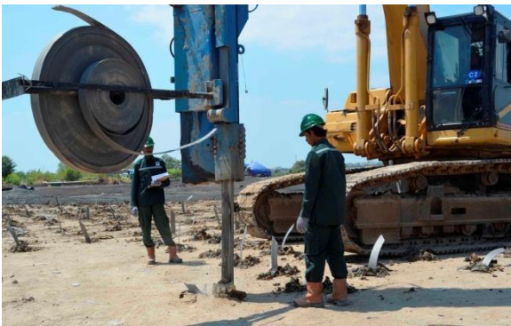
Gambar 45. Pemancangan mandrel ke tanah
