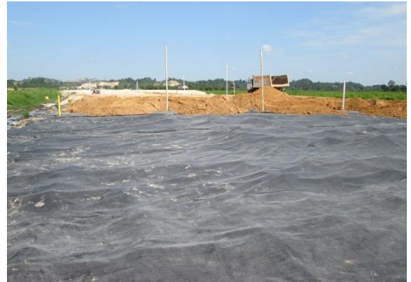
Gambar 94. Pemasangan geotextile
