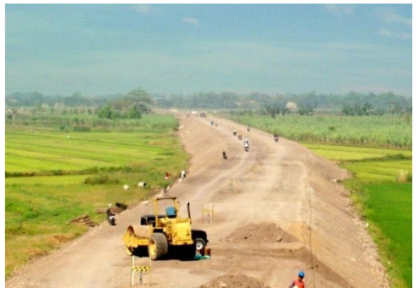
Gambar 56. Timbunan tanah preload
