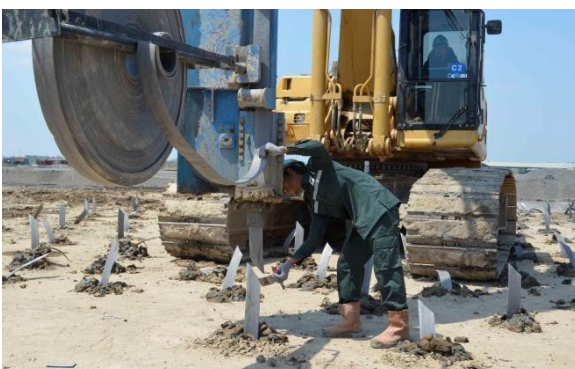
Gambar 46. Pemotongan PVD di atas tanah
