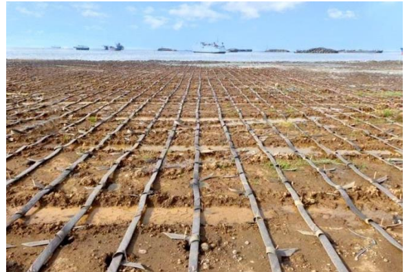
Gambar 47. Pemasangan PHD pada 1 PVD
