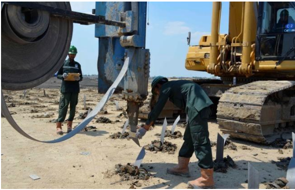
Gambar 44. Pemasangan sepatu pelat
