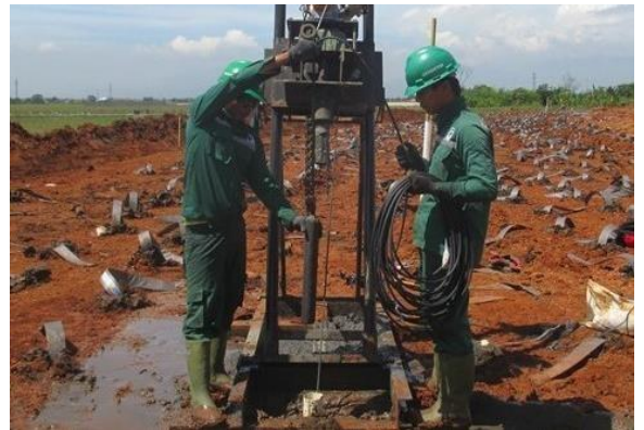
Gambar 54. Pemasangan pneumatic piezometer
