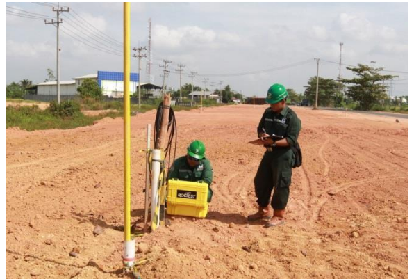
Gambar 99. Monitoring instrumen geoteknik
