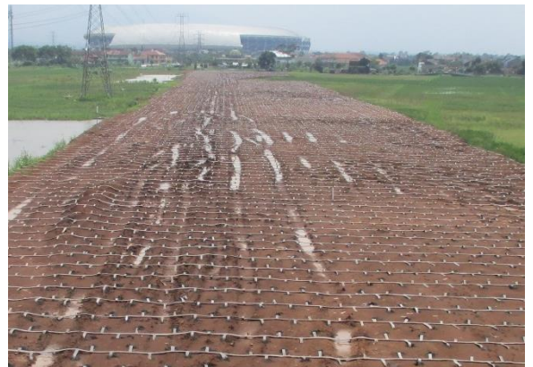
Gambar 48. Pemasangan PHD pada 2 PVD
