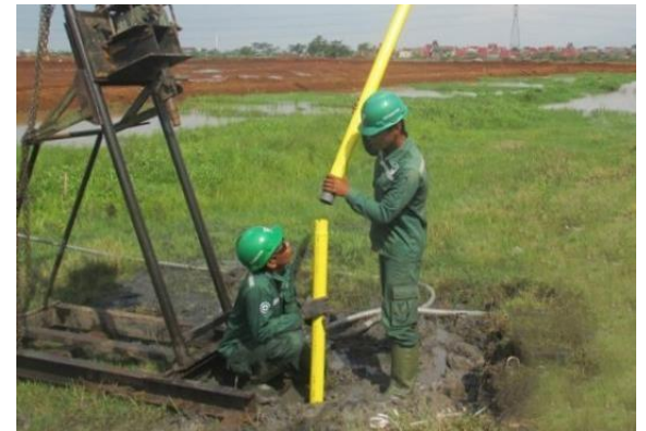
Gambar 55. Pemasangan inclinometer
