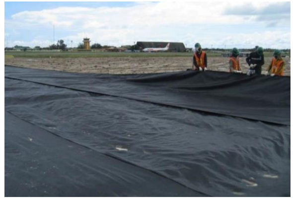
Gambar 86. Pemasangan geotextile
