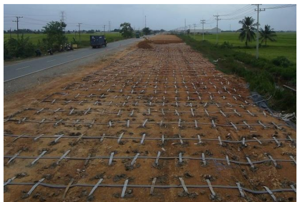
Gambar 49. Pemasangan PHD pada 2 PVD
