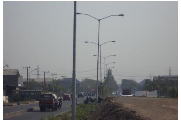
Gambar 9. Kerusakan tiang lampu jalan
