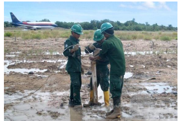
Gambar 88. Pemasangan instrumen geoteknik
