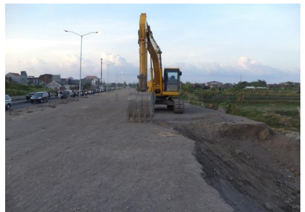
Gambar 74. Pembongkaran timbunan preload
