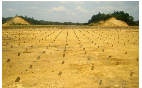
Gambar 43. Pola pemasangan PVD di lapangan
