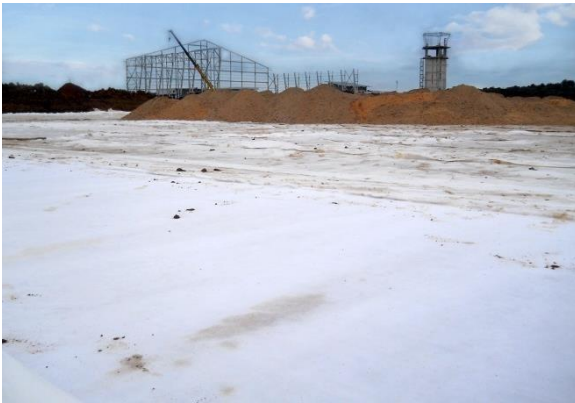
Gambar 90. Pemasangan geotextile
