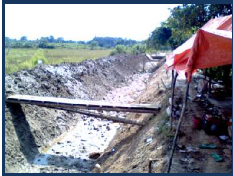
Gambar Foto Pengerjaan Awal Proyek Irigasi
