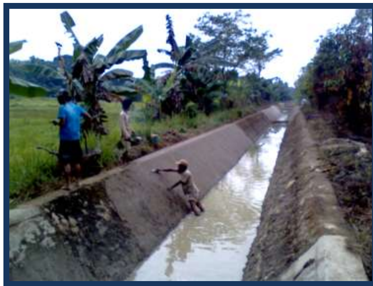
Gambar Foto Pengerjaan Pemasangan Batu
