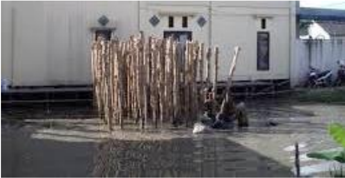
Gambar 4. Penggunaan kayu galam sebagai pondasi pada gambut.
