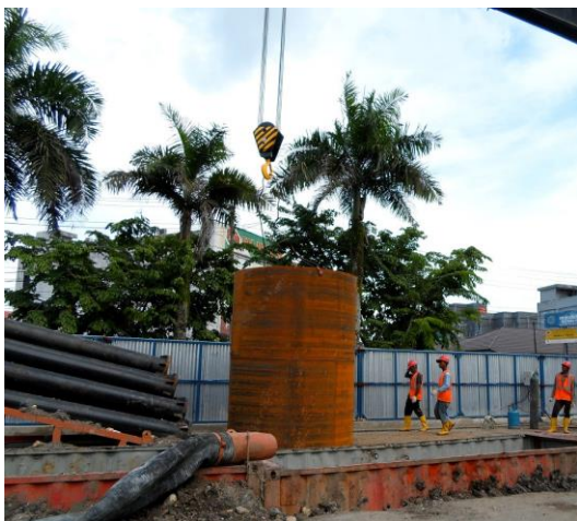
Gambar 2. Instalasi penempatan casing
