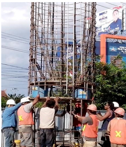
Gambar 13. Instalasi Load Cell & tulangan pada lubang pengeboran.
