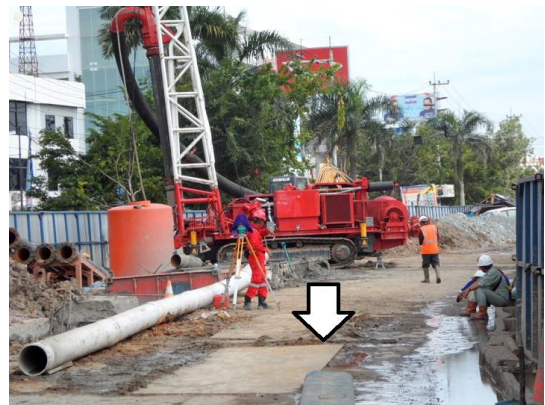
Gambar 7. Tanda panah putih menunjukkan normalisasi jalan akses pasca instalasi boredpile .
