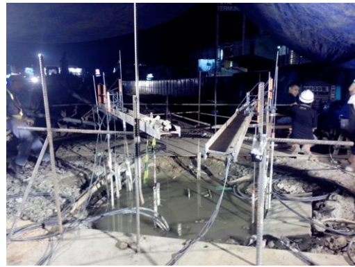
Gambar 14. Pemasangan instrumentasi pengujian Osterberg Cell.
