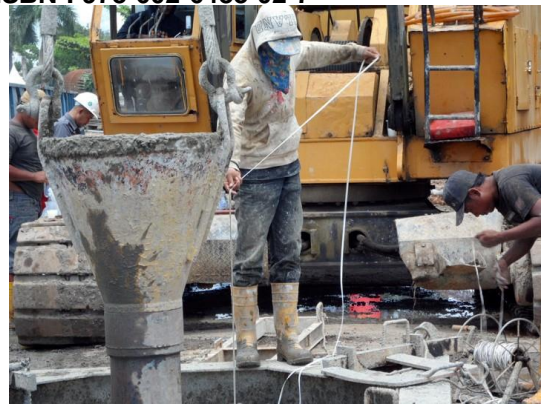
Gambar 6. Kontinuitas pengukuran kedalaman elevasi penuangan pasta beton
