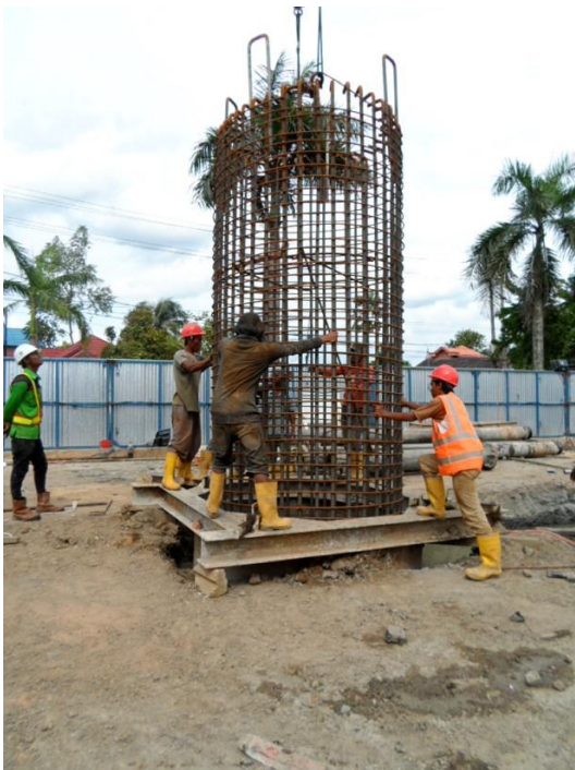
Gambar 5. Proses instalasi tulangan boredpile .
