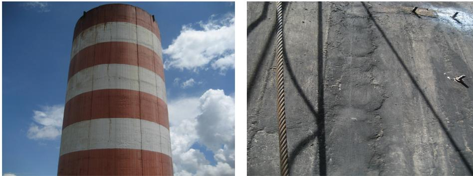
Gambar 1. Kondisi visual steel chimney reinforced concrete sisi luar dan sisi dalam pasca kebakaran
