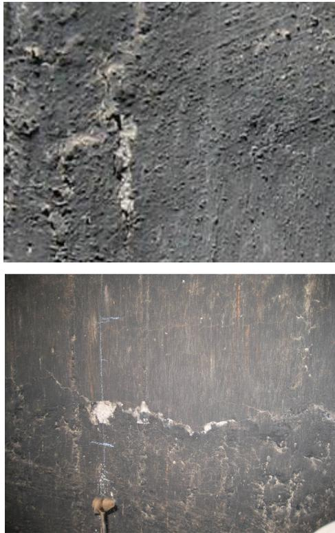
Gambar 2. Retak dan rompal beton pasca kebakaran
