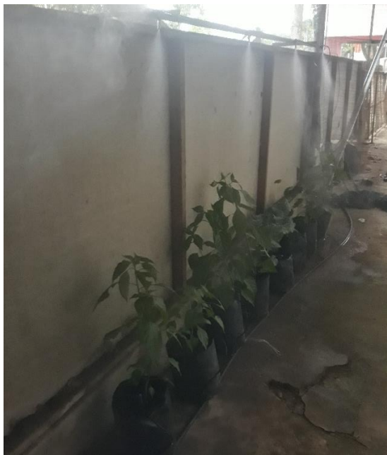
Gambar 10. pengkabutan ruangan greenhouse dengan nozzle
