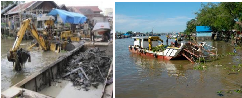
Gambar 2. Pengerukan dan Pembersihan Sungai dalam Perkotaan menggunakan Kapal Biyoko dan Kapal Sapu-Sapu (Sumber: Dokumentasi Bidang Sungai DPUPR Kota Banjarmasin, 2019)
