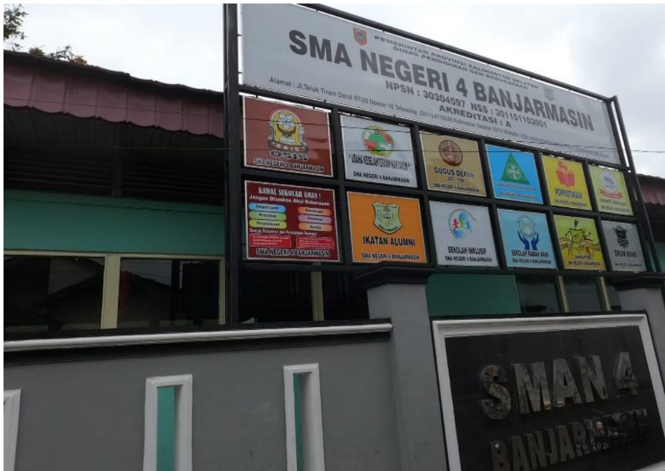
Gambar 2. Kondisi SMAN 4 Banjarmasin
