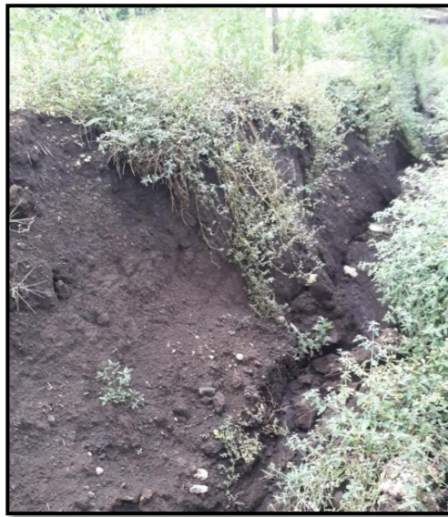
Gambar 2. Erosi Parit pada Lokasi Pengamatan Sumber: Dokumentasi Tim Peneliti, 2022
