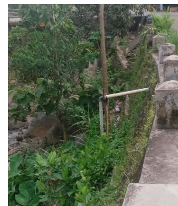
Gambar 2. Pipa langsung menuju badan air
