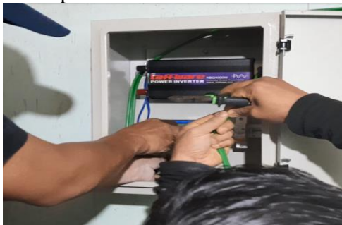
Gambar 6 Pemasangan Rangkaian Komponen di dalam Box Panel
