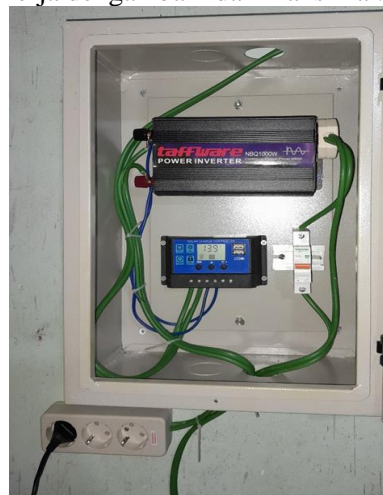
Gambar 6 Hasil Pemasangan Panel Catu Daya Energi Alternatif
