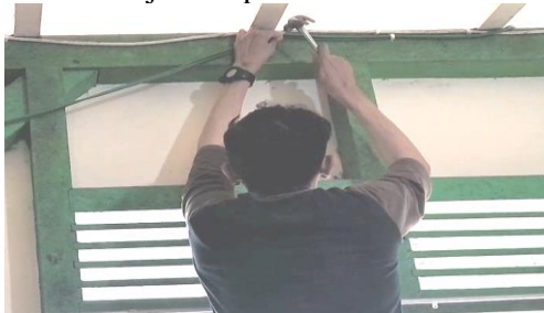
Gambar 5 Pemasangan Klem Kabel
