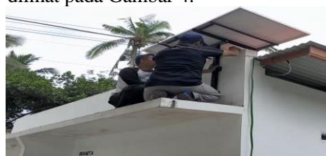
Gambar 4 Pemasangan Panel Surya
