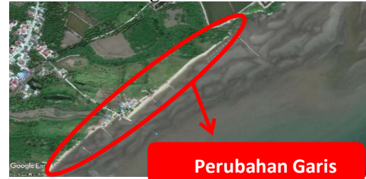
Gambar 1 Batas Pantai kersik Tahun 2007 Garis pantai yang hampir mengenai pondok wisata dan empang warga tertera pada Gambar 2.
