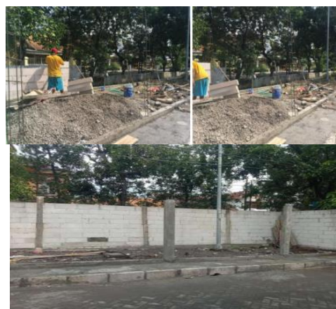
Gambar 4 Proses Pekerjaan Dinding dan Paving oleh pihak RW
