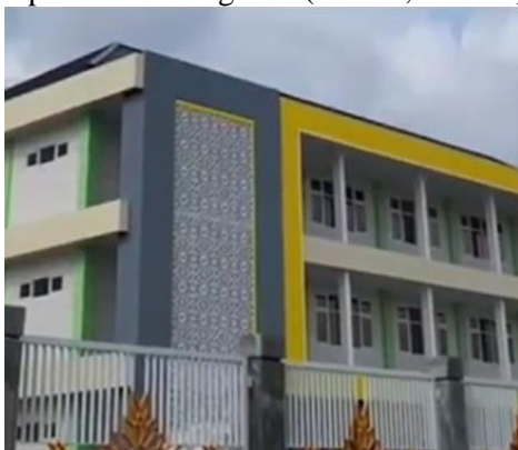
Gambar 1 Tampak Luar Gedung SD Muhammadiyah 1 Candi Labschool UMSIDA
