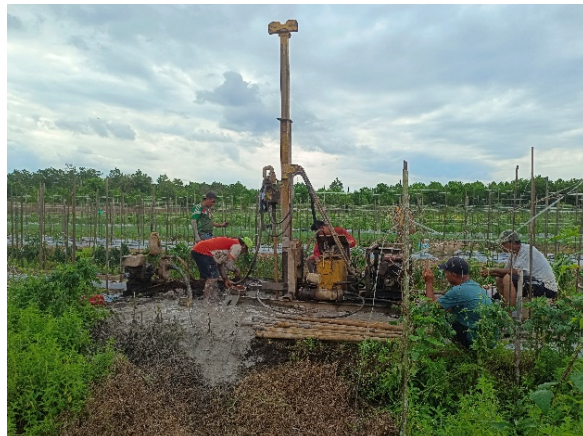
Gambar 4. Implementasi teknologi pembuatan sumur bor
