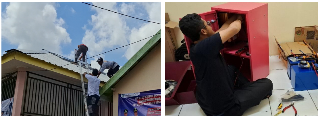
Gambar 4 Pemasangan panel solar cell dan sistem kelistrikan
