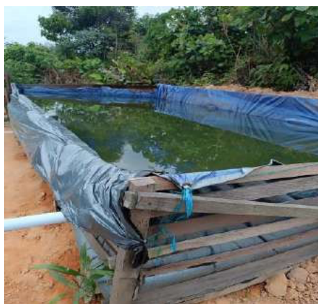
Gambar 2. Bak penampungan Air
