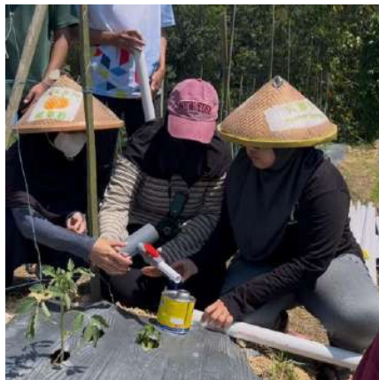
Gambar 3. Bak pemasangan pipa dan selang drip
