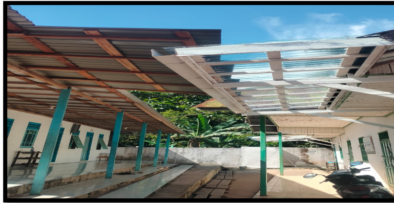
Gambar 4. Kanopi Penghubung yang Selesai Terpasang Menggabungkan Akses Asrama dan Kelas
