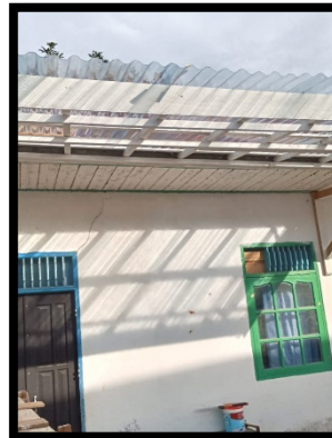
Gambar 2. Material Kayu Ulin dan Lembaran Penutup Atap Persiapan Pemasangan
