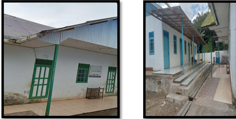
Gambar 1. Kondisi Eksisting Bangunan Asrama (Kiri) dan Ruang Kelas (Kanan) Sebelum Pemasangan Kanopi
