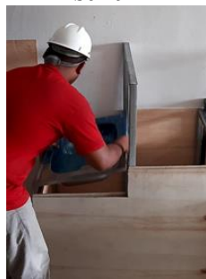
Proses pemasangan wastafel
