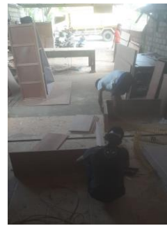
Proses pembuatan dinding
