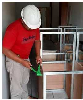
Proses konstruksi rangka
