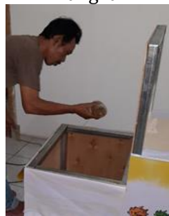
Proses pemasangan wastafel
