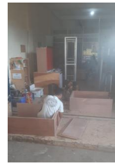
Proses pembuatan dinding
