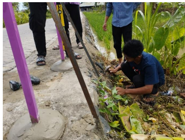
Gambar 3. Proses pemasangan tourism display board
