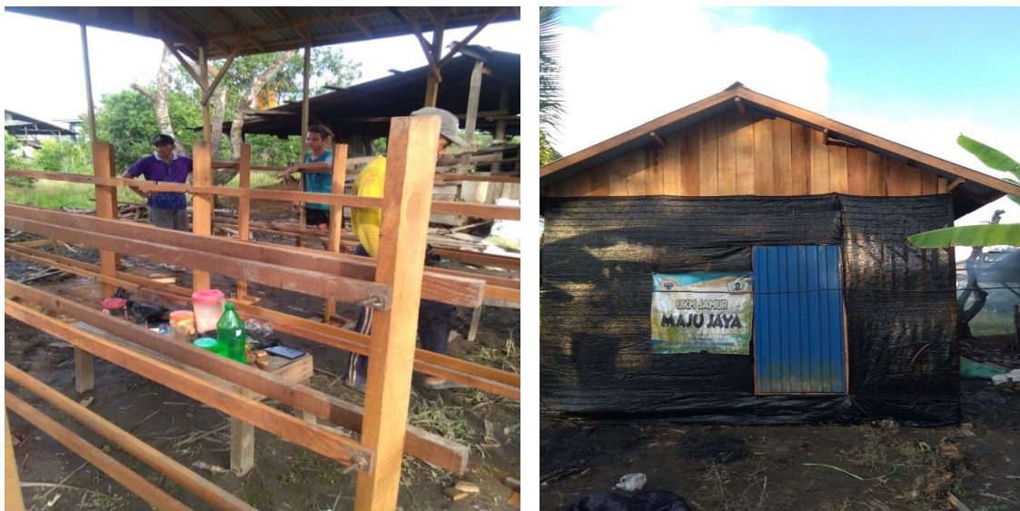
Gambar 3. Foto kondisi kumbung setelah rehabilitasi.
