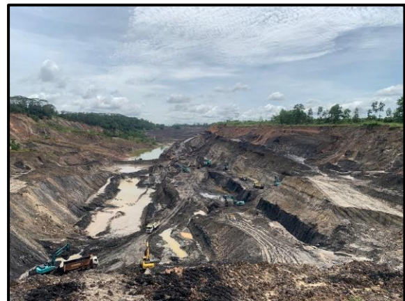
Gambar-17. Kondisi Front Kerja
