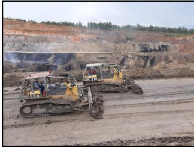
Gambar-7. Pembuatan Cross Slope Menggunakan Bulldozer
