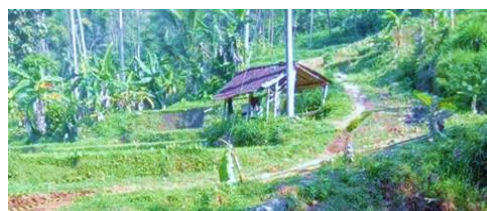
Gambar 1. Kondisi jalan Desa sebelum Diperbaiki
