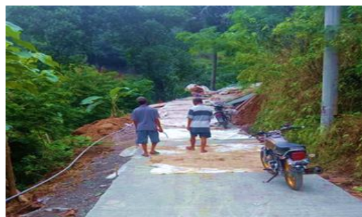
Gambar 2. Jalan Desa yang telah dicor beton
