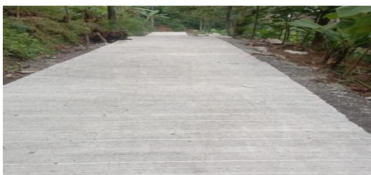
Gambar 4. Kondisi jalan setelah dibangun Sumber: Dokumentasi Peneliti, 2022
