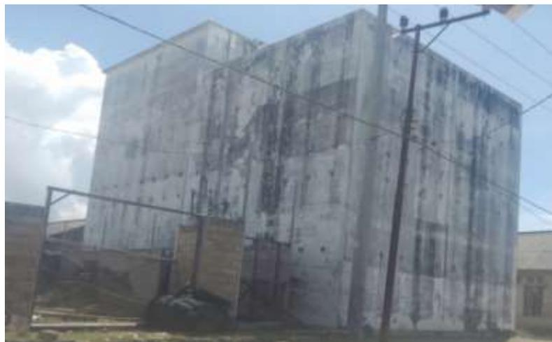
Gambar 2. Bangunan Rumah Walet dengan Ukuran Volume 864 m<sup>3</sup>.
