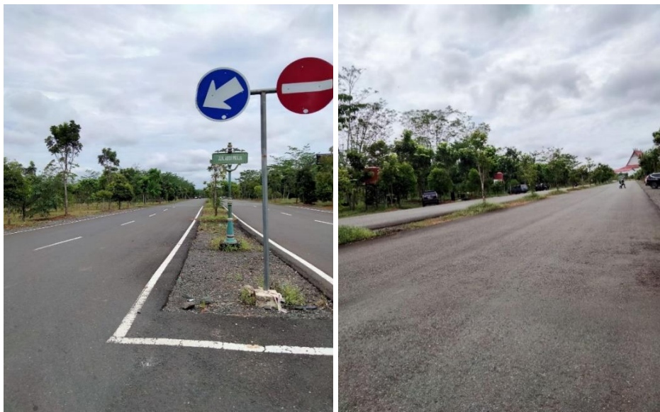
Gambar 3. Jalan Menuju TH2TI
