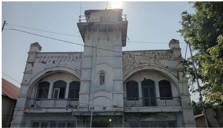
Gambar 1. Bangunan Eks Markas Pangkalan ALRI III Cirebon Sumber: Dokumentasi Peneliti
