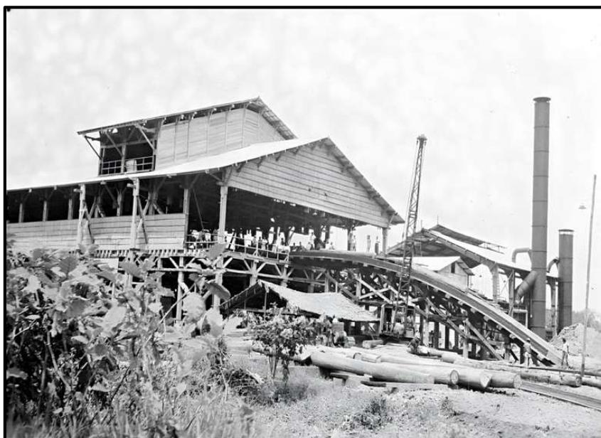
Gambar 2. Pabrik kayu Bruynzeel-Dajak, sebuah perusahaan kayu kongsi Belanda-Indonesia yang berada di Sampit, Kalimantan Selatan tahun 1949 (Sumber: Nationaal Museum van Wereldculturen)
