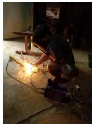
Gambar 3. Proses Perakitan Tiang Kerangka
